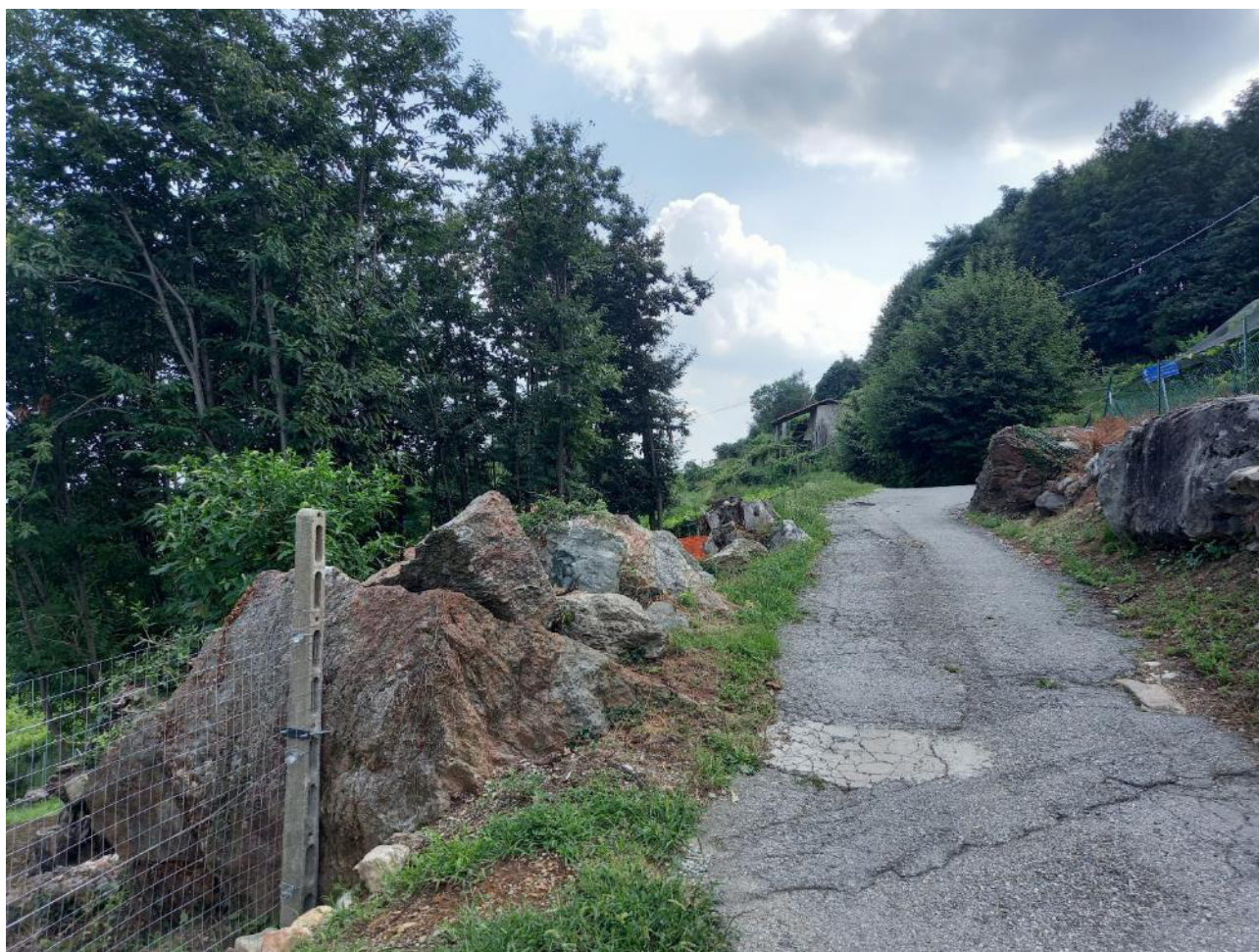
Figura 17: Manto stradale fortemente degradato con evidenti segni di cedimento sul lato di valle.
