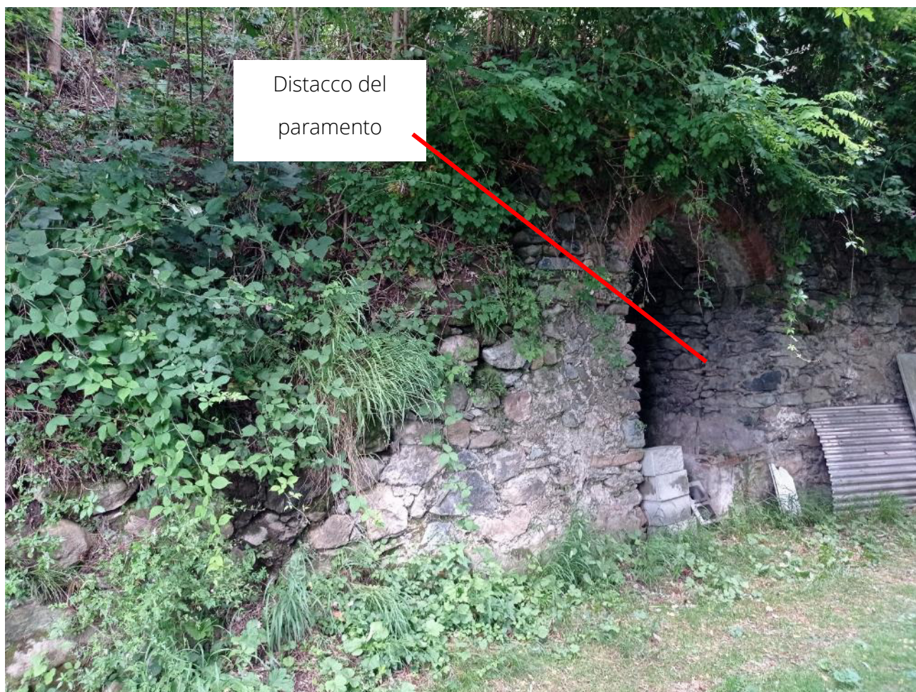
Figura 12: Evidenza di dissesti all'interno del locale ricavato a tergo del muro
