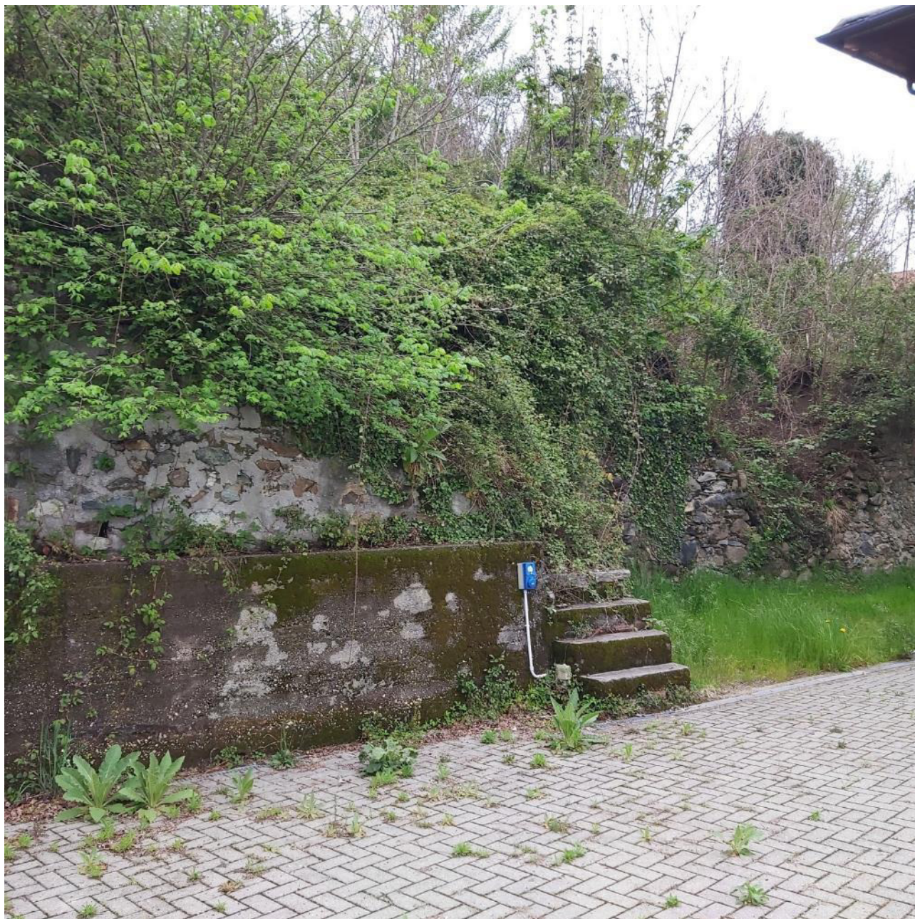
Figura 13: Tratto di muro esistente fronte piazza in cui sono stati messi in opera degli interventi sommari di messa in sicurezza. Antistante al cortile interno il muro è stato rafforzato alla base mediante la messa in opera di una sottofondazione in C.A. e mediante l'intasamento del paramento con malta cementizia, indubbiamente interventi di scarso pregio estetico.
